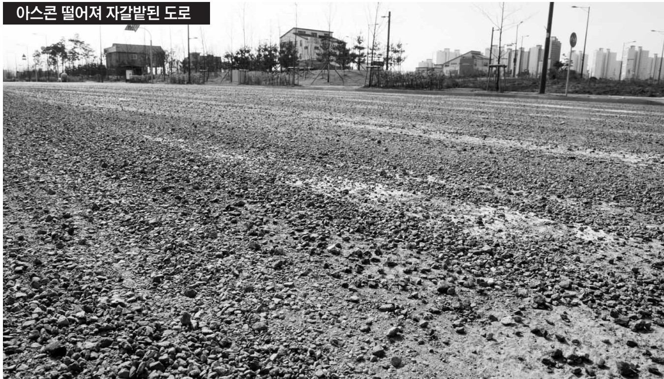
아스콘 떨어져 자갈밭된 도로 나주 빛가람혁신도시 북측도로(혁신로)가 떨어져나온 아스콘 재료를 인해 자갈밭으로 변하면서 운전자들이 큰 불편을 겪고 있다. 수북하게 쌓인 아스콘 조각들은 혁신도시 내 도로 곳곳에서 발견됐다. /최현배기자 choi@kwangju.co.kr
