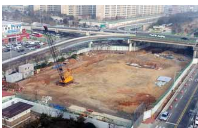
상습 침수지역인 목포시 상동 버스터미널 인근에 조성 중인 상동초기우수 처리시설 공사현장.
