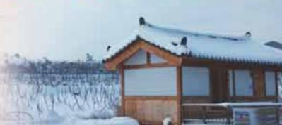
전통한옥을 집묵한 원목위주의 친환경 자재와 철구조로 이루어진 내진설계 내화판넬을 이용한 우수한 단열효과 및 화재를 미연에 방지 할 수 있는 안전하고 쾌적한 이동식 시스템한옥
