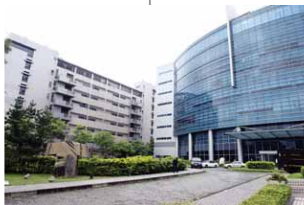
신주단지 안에 위치한 아파트형 공장.
