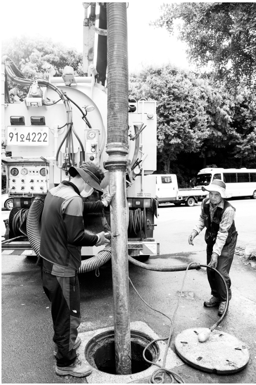
장마철 하수구 청소 광주 북구청 건설과 직원들이 4일 용봉동 주택가 이면도로에서 폭우에 대비, 하수준설차를 이용해 하수관로에 쌓인 모래 등 침전물 제거 작업을 하고 있다. /김진수기자 jeans@kwangju.co.kr
