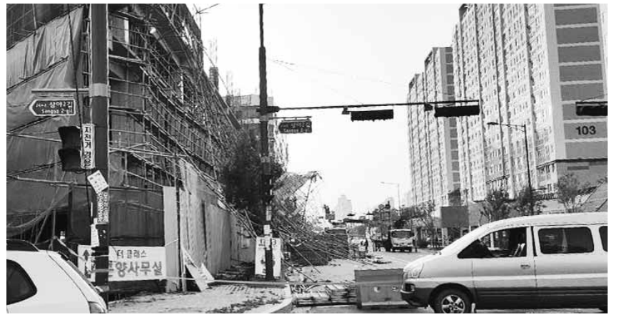
지지대 아래로 ‘아찔’ 22일 오후 나주시 빗가람동 중흥S클래스 아파트 건너편에 신축중인 상가가 관리부실로 지지대가 도로로 쏟아져 내려 행인과 차량을 덮칠뻔한 아찔한 순간이 연출됐다. <독자 배대성씨 제공>
