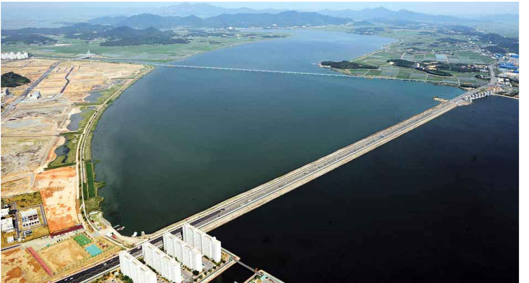
지난 1981년 목포시 옥암동과 영암군 삼호읍 나불리 사이의 영산강 하구를 가로막고 쌓은 영산강하구둑 전경. 농업용수와 농지 확보를 통한 식량 증산 등을 목표로 건설된 하구둑은 그러나 영산강과 바다를 단절시켜 수질 악화, 어족자원 훼손, 갯벌 매립 등 직·간접적 부작용을 불러왔다. 〈광주일보 자료사진〉
