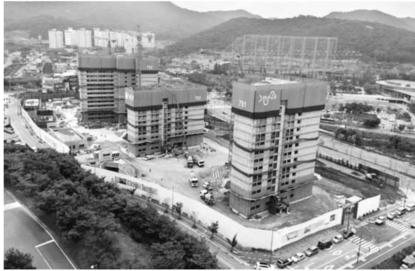
광주 효천2지구 행복주택 건설 현장.
