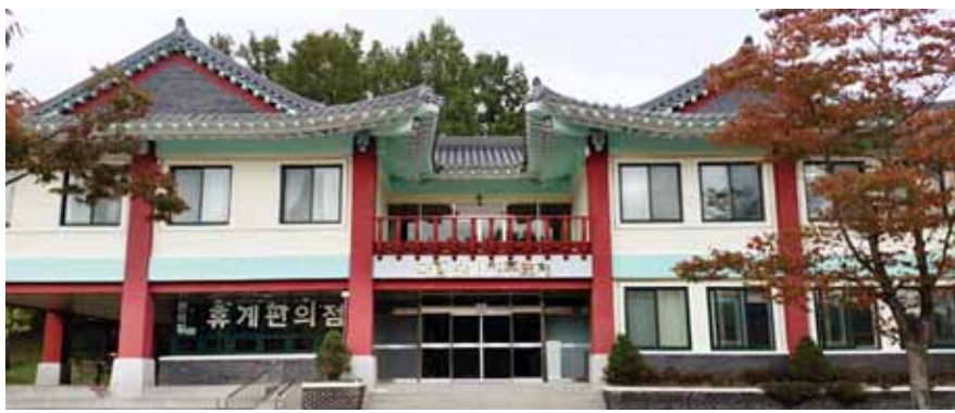
불법 건축물로 지어져 2년 넘게 사용중인 국립5·18민주묘지관리소 관리동.
