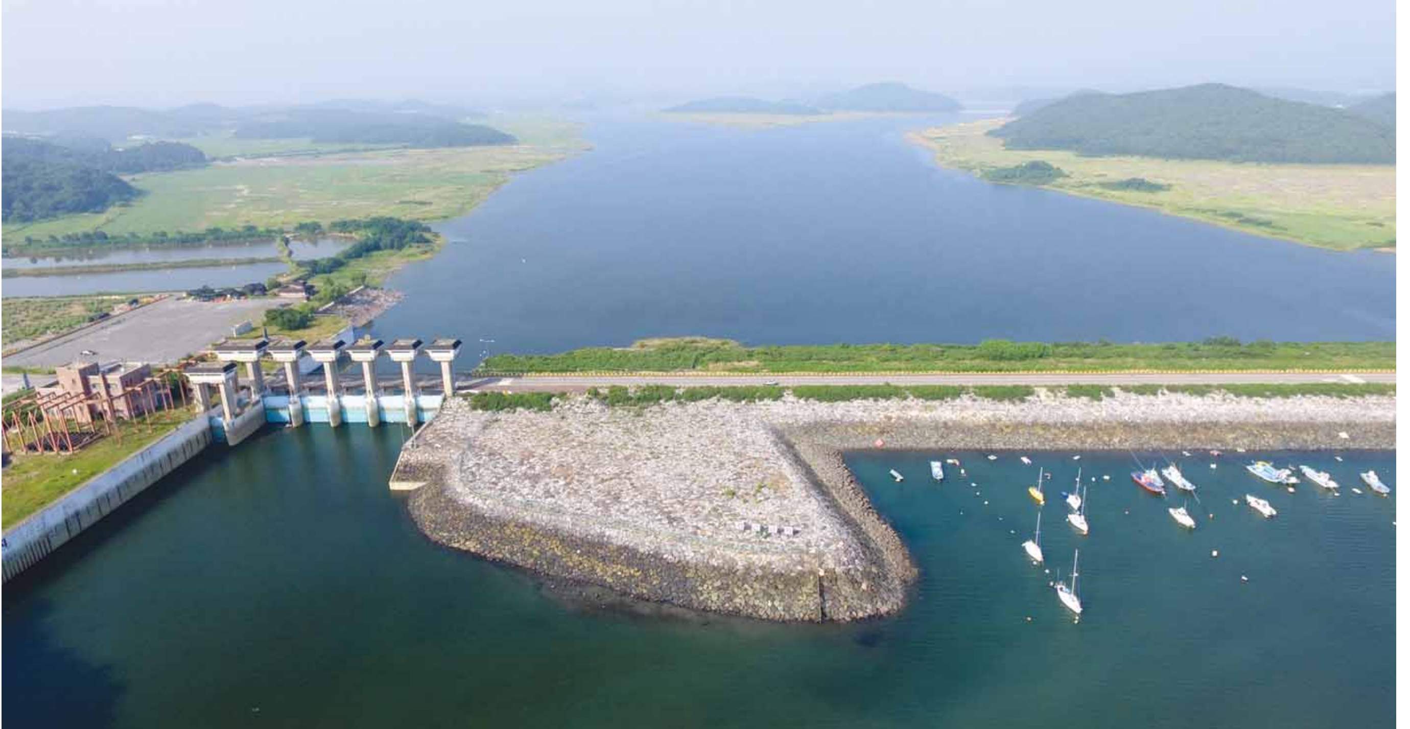
충남 보령시 오전면과 천북면을 잇는 보령 방조제는 길이 1082m로 지난 1997년 준공됐다. 방조제가 들어서면서 해수 유입은 차단됐고 인공 호수인 보령호(사진 위쪽)가 만들어졌다. 충남도가 지난 7월 보령호 수질 개선과 하구 갯벌 복원을 위해 방조제 문을 열고 해수를 유입시키는 역간척 사업 계획을 발표하자 담수화사업을 벌여온 한국농어촌공사가 반발하고 있다. <충남도 제공>
