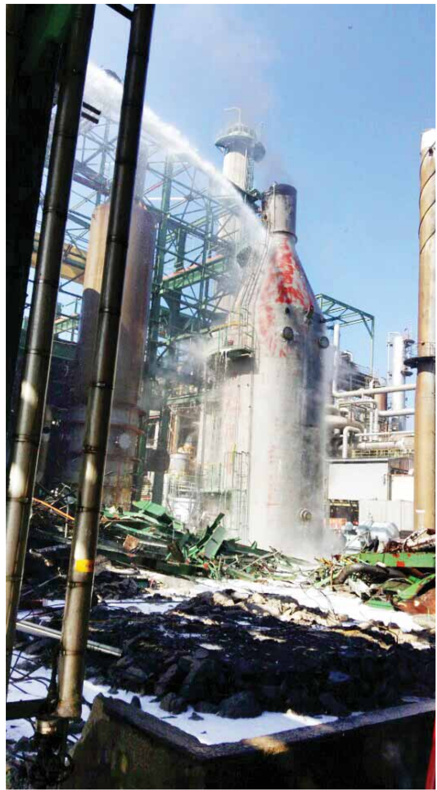
여수산단 또 불 15일 낮 12시 7분께 여수시 적량동 S화학 공장에서 불이 났다. 불은 출동한 소방대원들에 의해 30여분만에 진화됐으며, 인명피해는 없는 것으로 확인됐다. 경찰과 소방당국은 "골목 등 일부 시설 철거 작업 중 불이 났다"는 관계자 진술을 토대로 화재원인을 조사 중이다. <여수소방서 제공>
