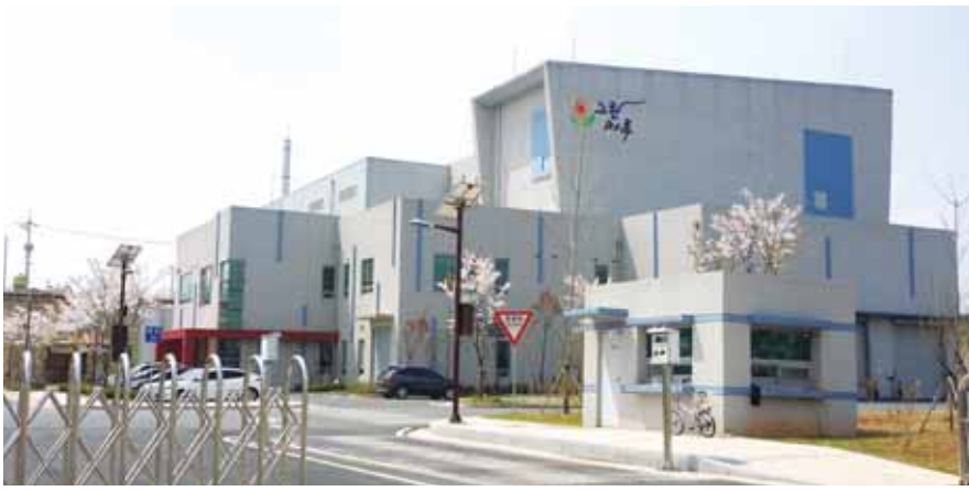
부실시공 의혹을 받고 있는 나주 가연성 생활폐기물 처리시설.
