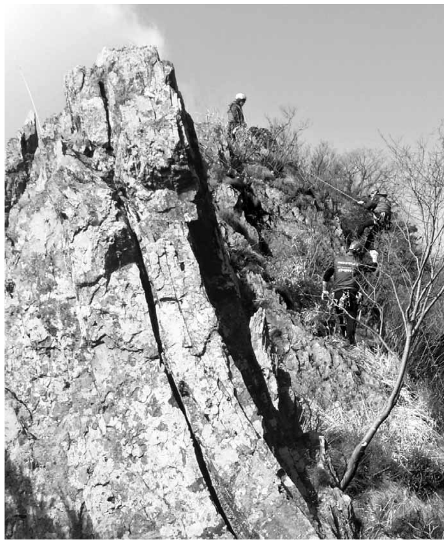
봄 해빙기를 맞아 내장산 국립공원사무소 직원들이 세레봉 일원에서 낙석 우려가 있는 암석을 제거하는 모습. (광주일보 자료사진)
