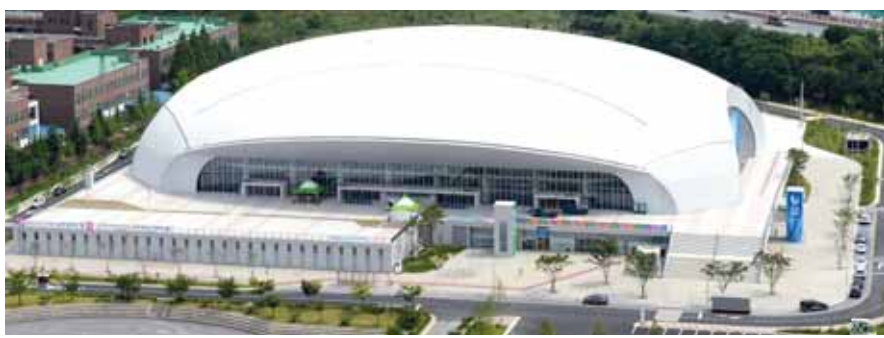
2019 광주세계수영선수권대회 주경기장인 남부대 시립 국제수영장 전경.
