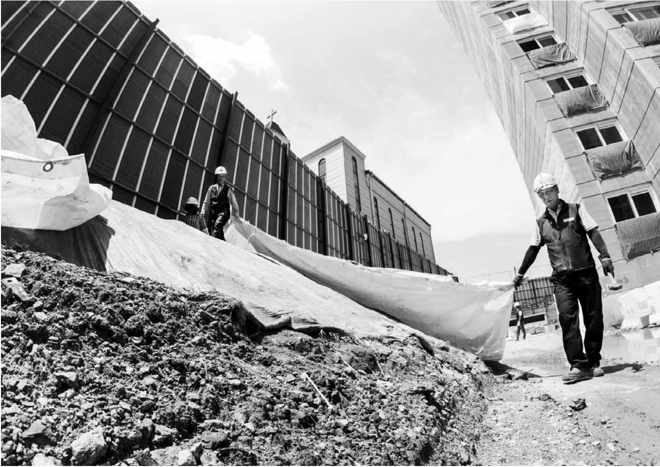
광주시 북구 용두동에 있는 한 아파트 공사현장에서 최근 북구청 공동주택과 직원과 작업자들이 장마철 집중 호우 등에 대비해 경사면의 토사유출을 막는 비닐포장을 씌우고 있다.
