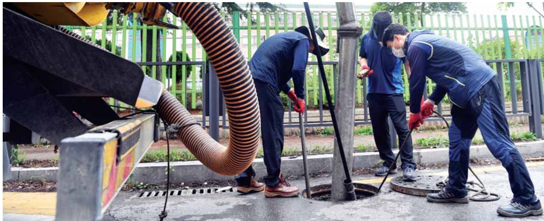
집중호우 대비 하수관 정비 광주시 북구청 건설과 하수팀 직원들이 10일 문흥동 한 이면도로에서 준설차를 이용해 하수관에 쌓인 퇴적물을 제거하고 있다. 집중호우에 대비해 하수 배출을 원활히 하기 위한 조치다. /*최현배기자 choi@kwangju.co.kr
