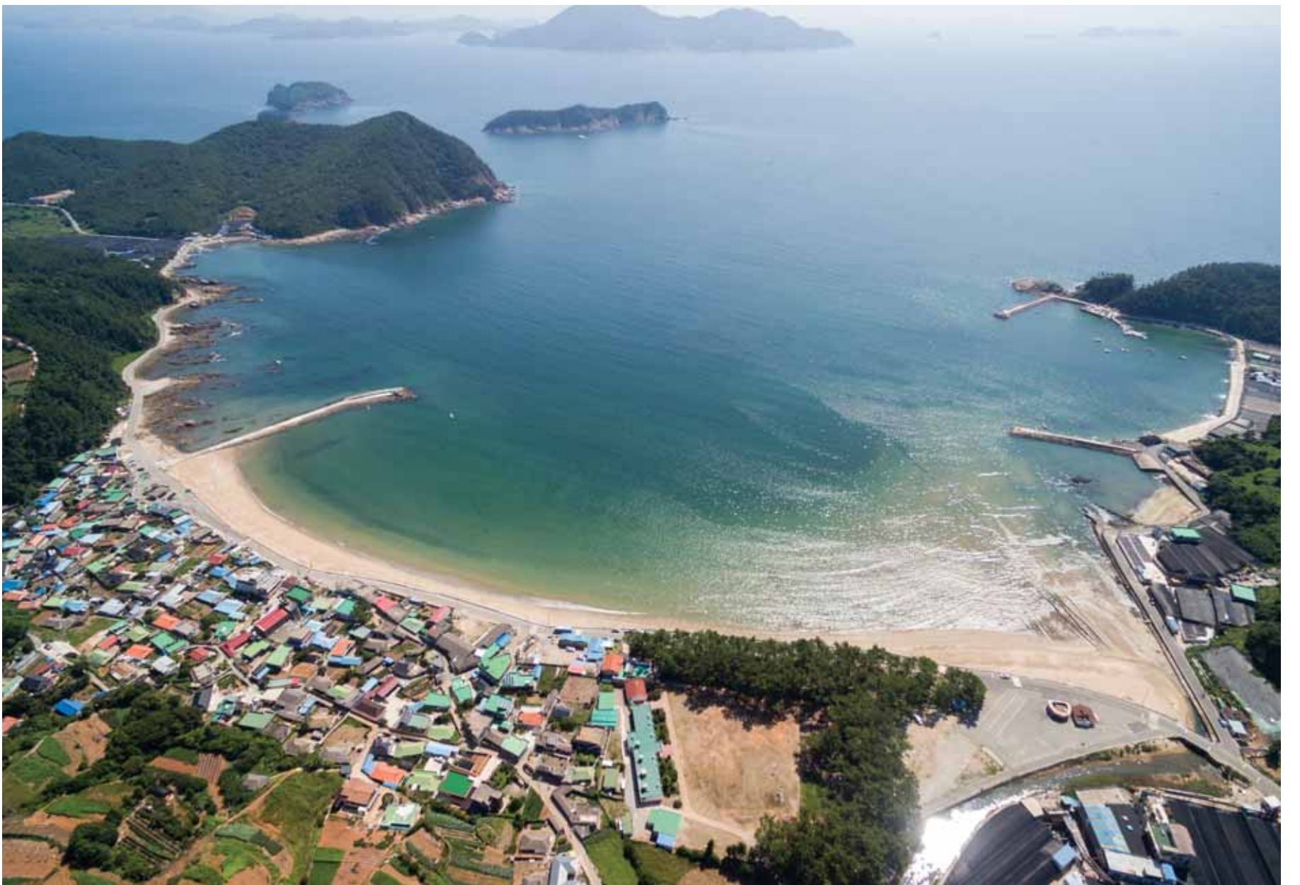
동고마을을 감싼 부드러운 산세와 1.5km에 이르는 해변은 보는 이에게 아늑함을 선사한다. 드론으로 촬영한 동고마을 전경.
