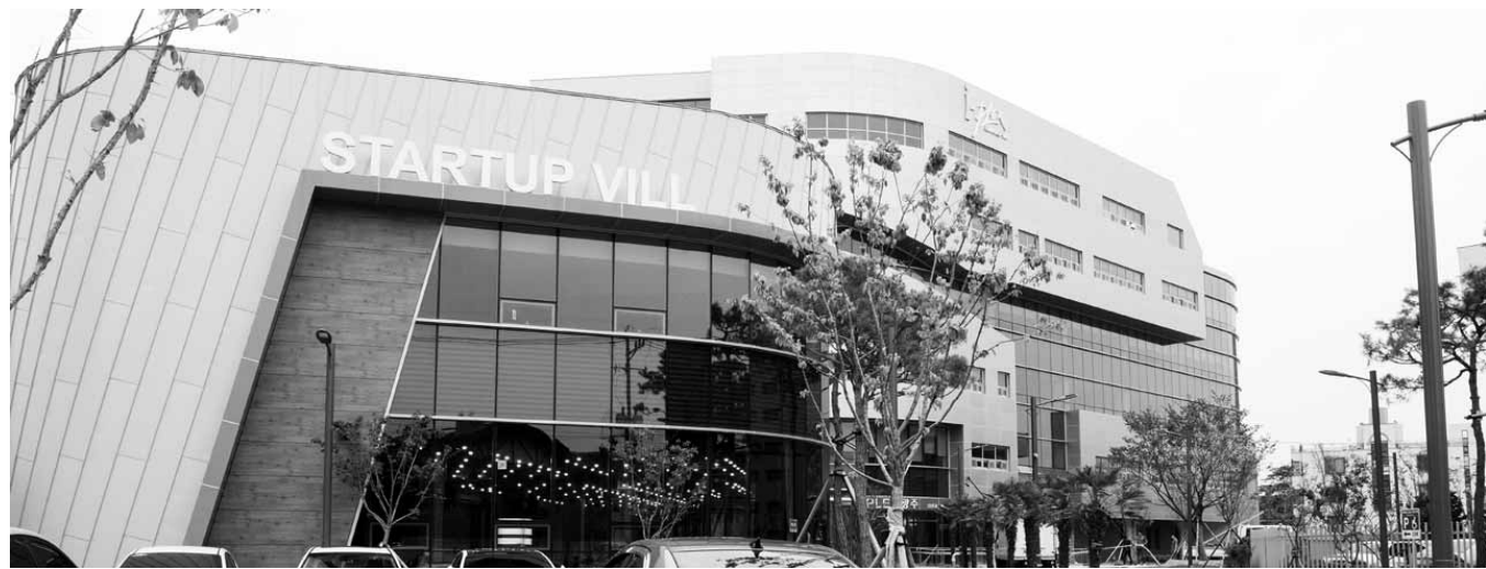
광주시 동구 동명동에 위치한 청년 기술창업 플랫폼 'I-PLEX광주' 전경.
