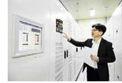
평창 풍력단지에 설치된 ESS(에너지저장장치) 일부인 PCS(전력변환장치)를 관계자가 살펴보고 있다. <효성 제공>
