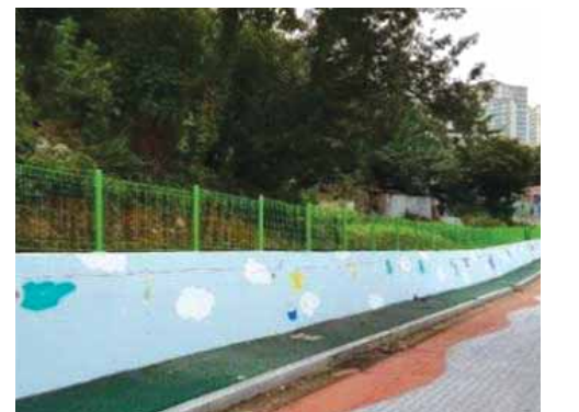
옹벽 정비와 도로 도색해 걷고 싶은 거리로
