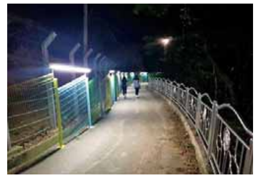
차단 펜스와 안심등 설치
