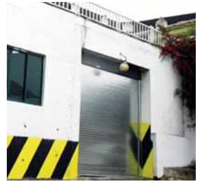
출입 차단막 설치
