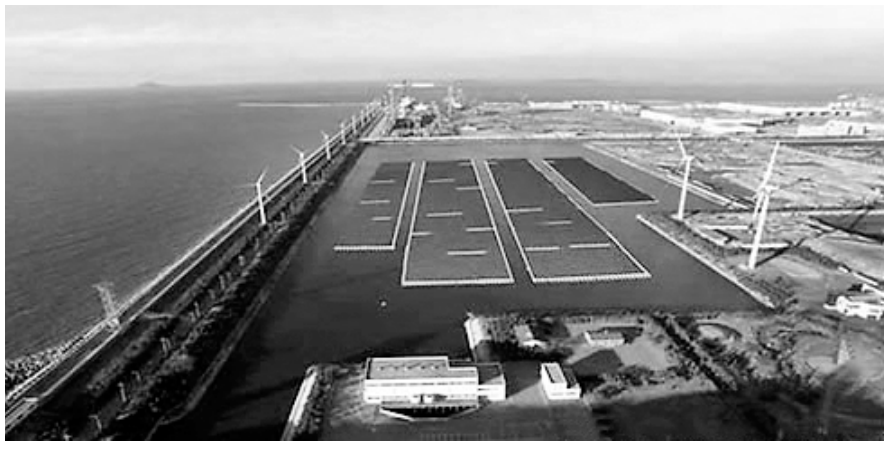
군산 수상태양광발전소 조감도.
