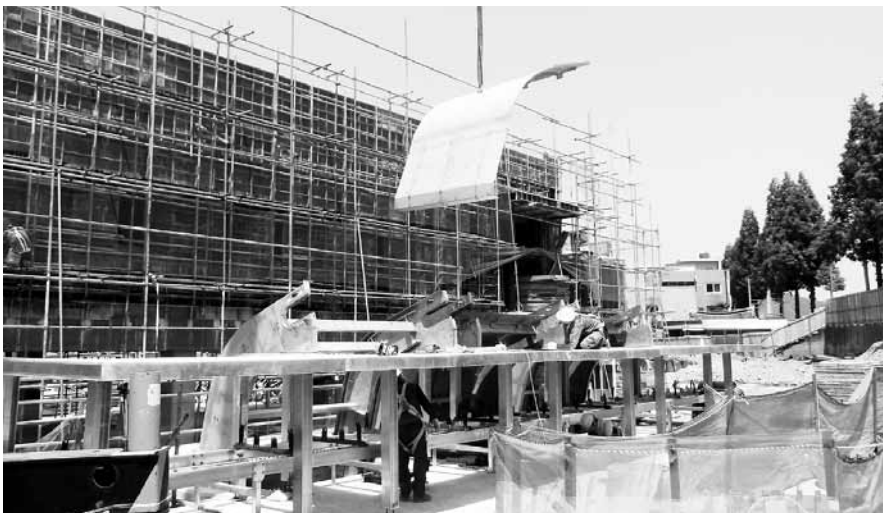
쓰레기 유입을 방지하는 장치인 제진기 설치 모습.
