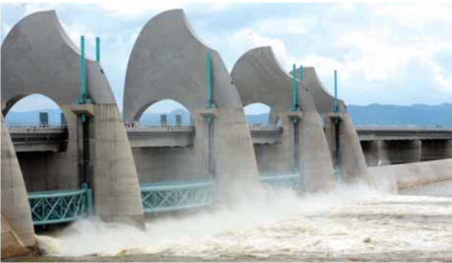
나주 영산강 승촌보 전경. 최근 보 개방으로 농업용수 확보에 어려움을 겪고 있다는 민원이 잇따르면서 나주시가 한국수자원공사에 대책 마련을 요구, 주목된다.
