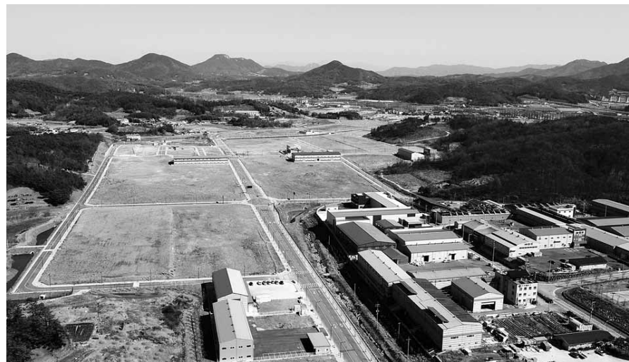
담양읍에 위치한 에코하이테크 담양산업단지 전경.
