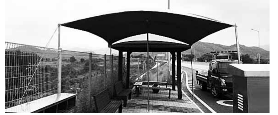
고속도로 졸음쉼터와 졸음쉼터에 설치된 그늘막.
