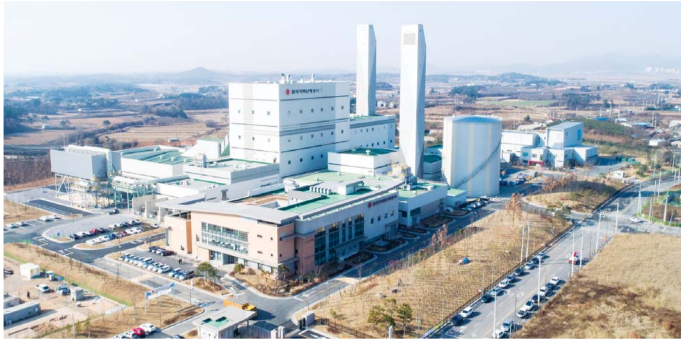
나주시가 혁신도시에 집단 열에너지를 공급하게 될 열병합 발전소의 건축물 사용 신청을 최종 승인했다. 나주 산포면 신도산단 내에 들어선 한국지역난방공사 열병합발전소 전경. <광주일보 자료사진>
