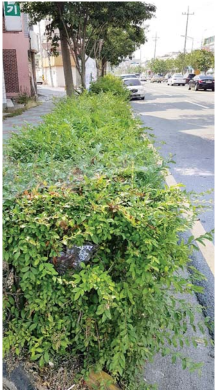
차도와 인도를 구분하기 위해 설치된 차수벽의 철제가 심하게 부식되고 수목이 웃자라 도시미관을 해치고 있지만 보수의 손길은 찾아보기 힘들다.
