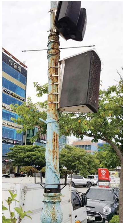
해마다 50만명이 찾는 평화광장에 설치된 가로등의 90%가 녹슬고 부식돼 흉물로 전락했지만 당국은 1년이 넘도록 방치해 놓고 있다.
