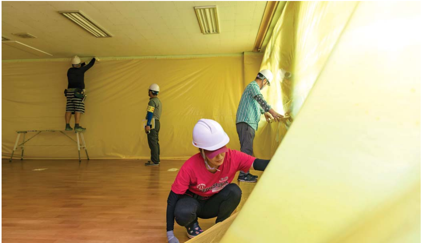
방학중 학교 석면 철거 작업 6일 오전 광주 광산구 어룡초등학교에서 석면이 들어간 천정텍스를 교체하기 위해 작업자들이 교실 내부에 비닐을 씌우는 보양작업을 하는 중이다. 광주시교육청은 어룡초와 동신여중 2곳에 대해 여름방학이 끝나는 시점까지 무석면 텍스로 천정을 교체할 계획이다. /김진수 기자 jeans@kwangju.co.kr
