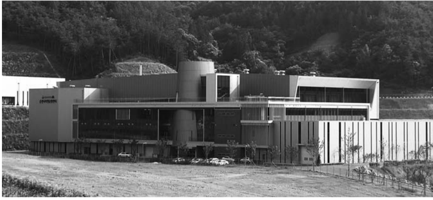
순천 자원순환센터 전경.
