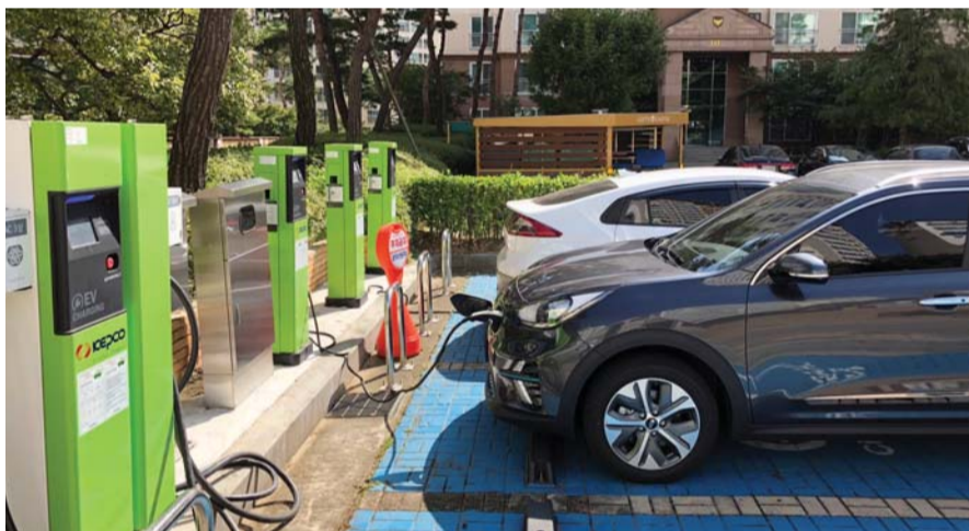
아파트에 설치된 전기차 충전기.
