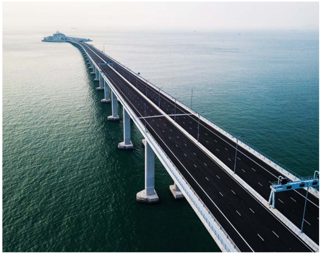
55km 세계 최장 중 강주아오 대교 개통 23일(현지시간) 개통된 세계 최장 강주아오 대교의 모습. 이날 중국 광둥성 주하이항에서 개통식을 가진 강주아오 대교는 홍콩과 주하이, 마카오를 잇는 총연장 55km로 22.9km의 교량 구간과 6.7km 해저터널 구간, 터널 양쪽의 인공섬, 출입점 시설 등으로 구성됐다. /연합뉴스
