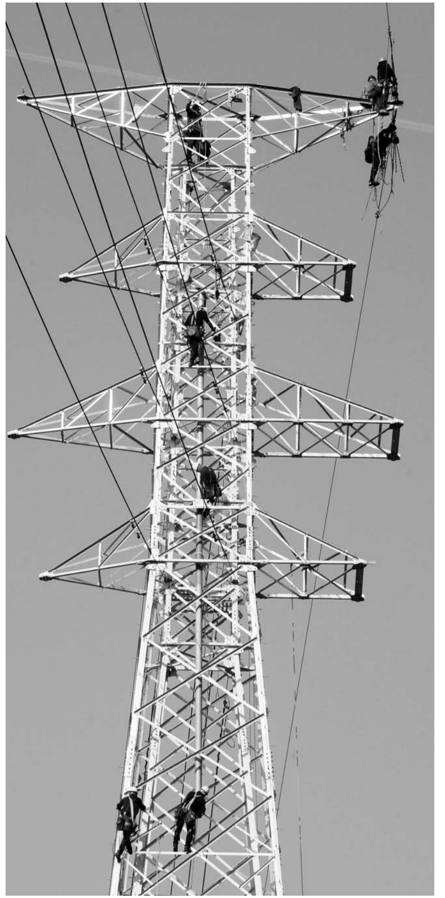
‘극한 작업’ 송전탑 전선 설치 전력산업 근로자들이 7일 광주시 동구 소재 동에서 30m 높이 송전탑에 올라 전선을 설치하고 있다. /나명주 기자 mjna@kwangju.co.kr
