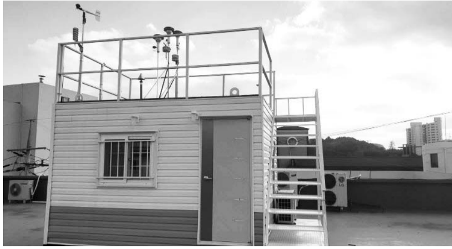
최근 영광읍사무소 옥상에 설치된 대기오염 측정망 시설.
