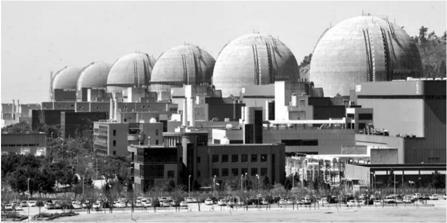
영광 한빛원자력발전소 전경. 민관합동조사단 조사 결과 영광 한빛원자력발전소 4호기 격납건물 외벽에서 8cm 이상 공극이 다수 발견됐다. <광주일보 자료사진>
