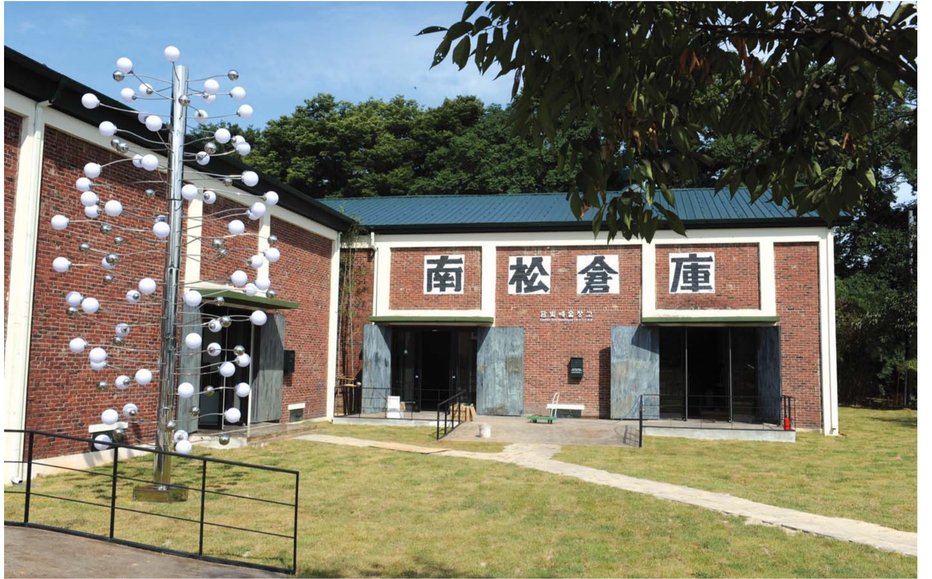
1960~70년대 지어진 옛 양곡창고를 리모델링한 담빛예술창고 전경. 건물 왼쪽에 자리한 미디어아티스트 정운학의 작품 '빛의 열매' (2015년 작)가 눈길을 끈다.
