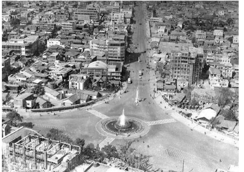
1969년 금남로 확장 공사 직후의 금남로 모습. 전일빌딩은 증축공사가 한창 진행중이었다.
