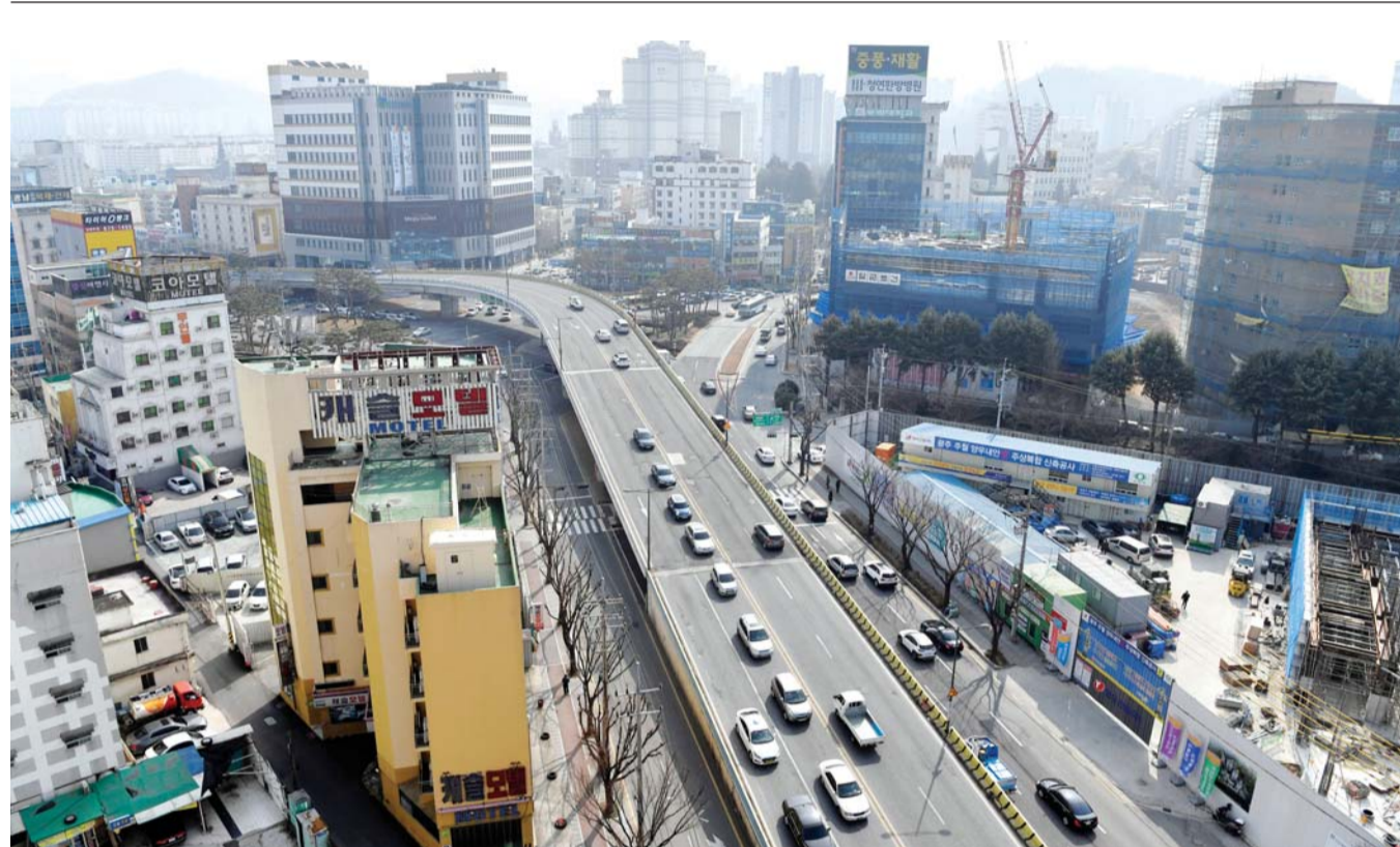
광주의 대표적인 교통 요충지인 광주 남구 백운광장에 차량들이 신호에 맞춰 통행하고 있다. 이 일대에는 을 상반기부터 하수관거 설치, 백운고가 철거 및 지하차도 건설, 도시철도 2호선 공사 등이 예정되어 있어 큰 교통혼잡을 예고하고 있다.
