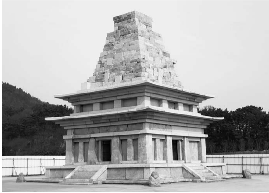
국내에서 가장 오래되고 가장 큰 석탑인 전북 익산 미륵사지 서쪽 석탑(국보 제11호)이 하늘을 향해 우뚝 솟아 있다. 2001년 본격적인 해체 작업에 들어간 석탑은 그동안 가설 덧집에 둘러싸여 있어 야외에서는 그 모습을 볼 수 없었다.
