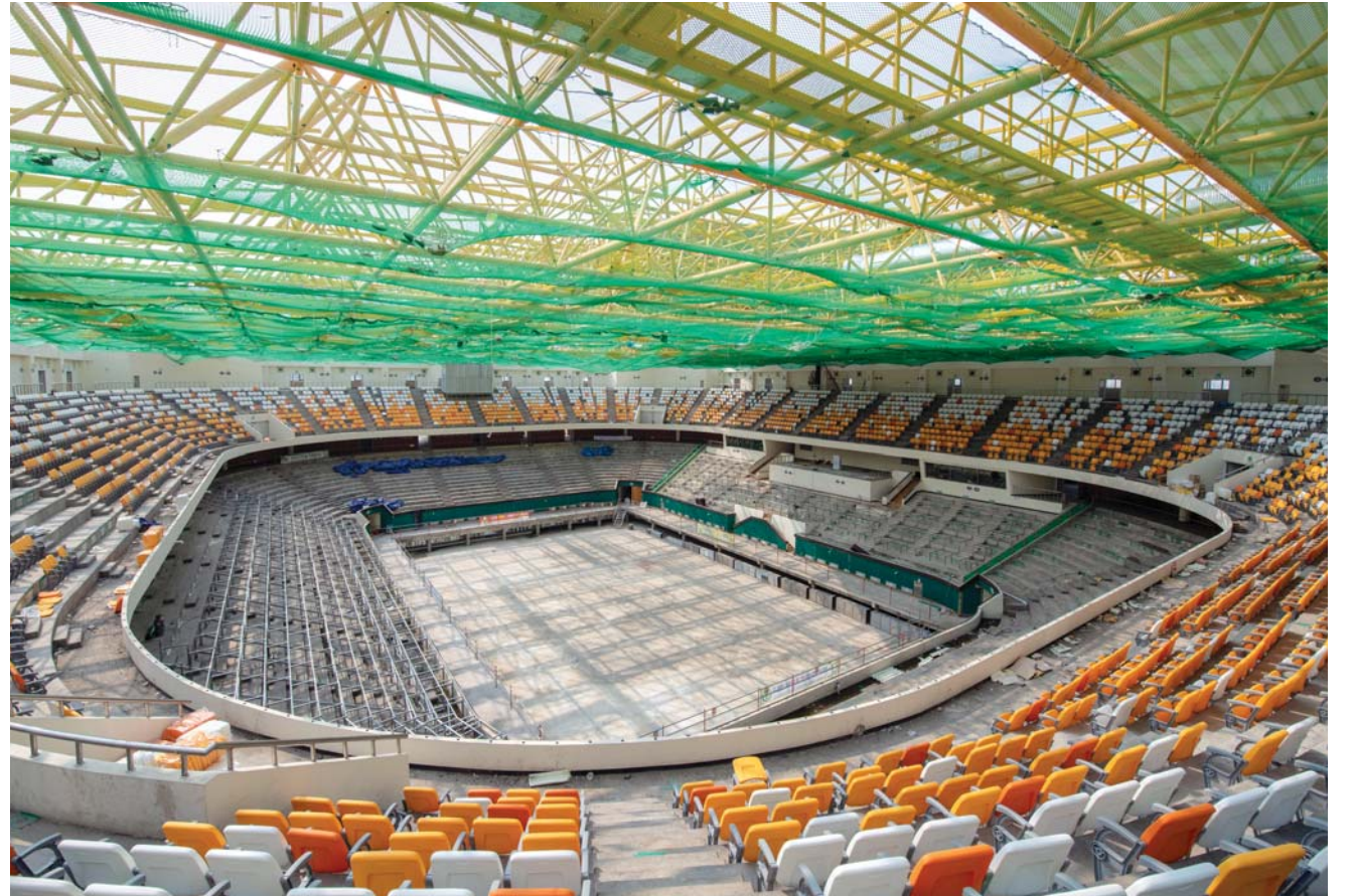
염주체육관 수영대회 준비 한창 2019 광주세계수영선수권 대회 준비가 순조롭게 이뤄지고 있는 가운데 19일 염주체육관 관람석 철거 공사를 마치고 풀장 설치 작업이 한창이다. 관람석 1320석 규모의 염주체육관은 아티스틱스위밍 경기 시설로 공정률은 42%진행중이다.
