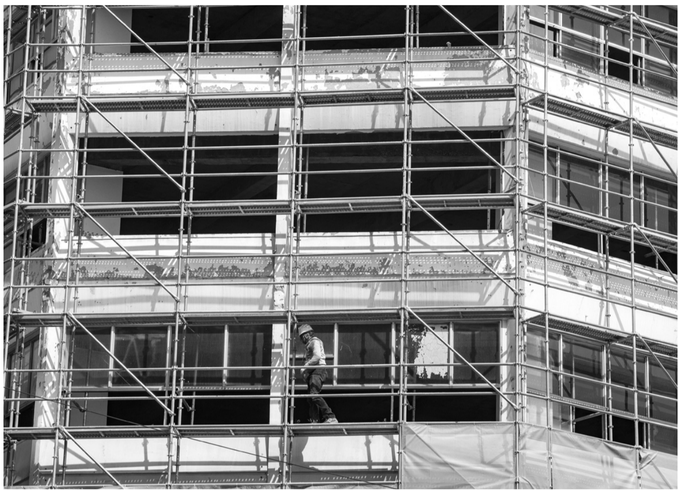
전일빌딩 리모델링 공사 현장 8일 광주시 동구 금남로 전일빌딩 리모델링 공사 관계자가 건물 외벽에 설치된 비계를 점검하고 있다. 전일빌딩 내부와 외벽에서는 5·18 당시 헬기기총 소사 총탄 흔적이 200여개 발견됐다. 광주시는 총탄 흔적을 완전 보존한다는 방침이다. /김진수 기자 jeans@kwangju.co.kr
