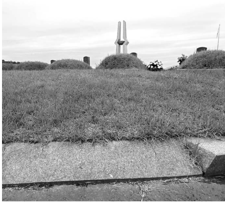
국립5·18민주묘지 제1묘역 진입로에 설치된 경계석. 경사도가 큰 경계석 때문에 휠체어를 탄 장애인들은 혼자서 묘역 참배를 할 수 없는 상황이다.
