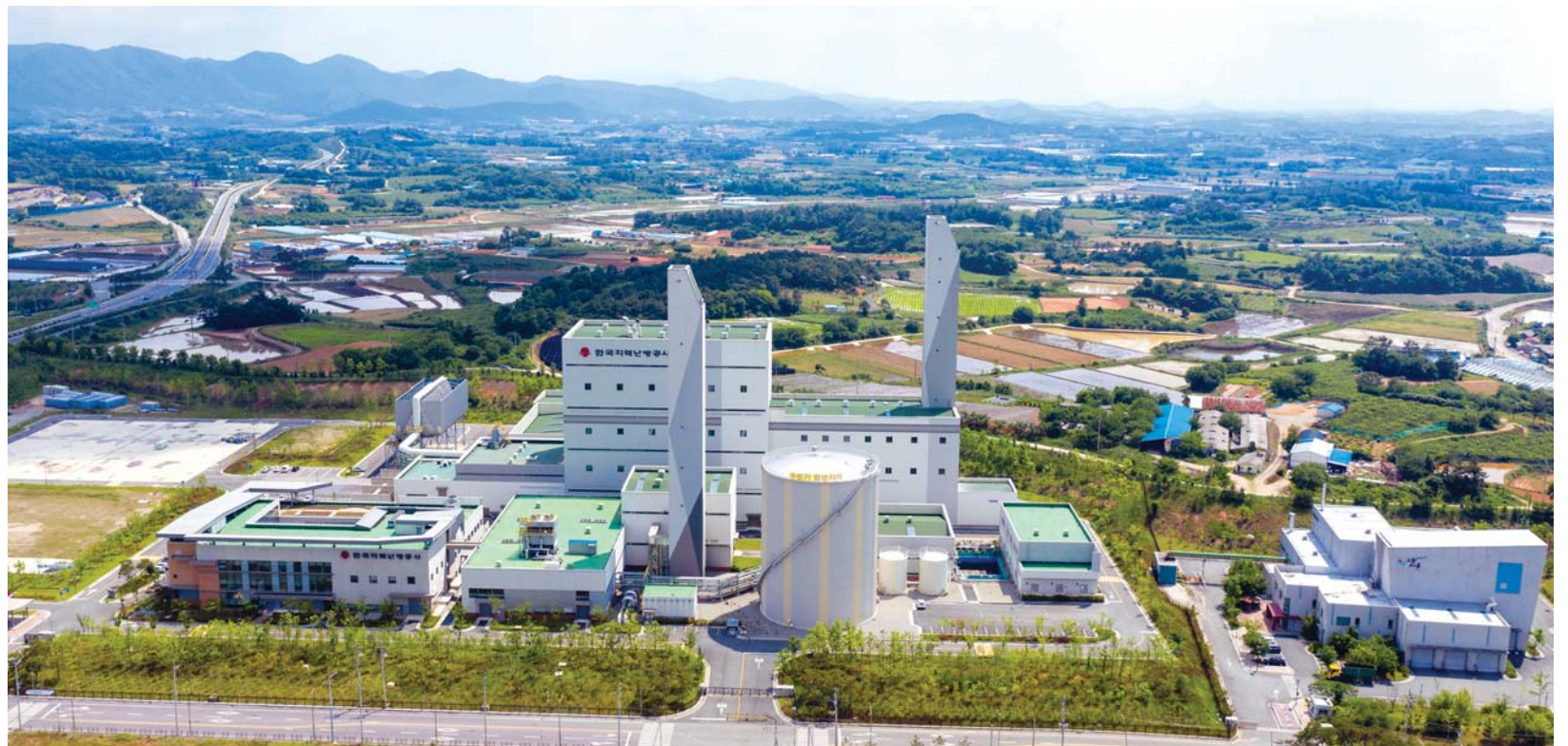
광주·전남 공동혁신도시에 들어선 열병합발전소 전경. 광주·나주·순천·목포에서 배출되는 가연성 쓰레기로 만든 고형연료를 태워 혁신도시에 전기와 열을 공급 할 예정이던 발전소는 현재 주민 반발로 정상 가동이 무기한 연기됐다.
