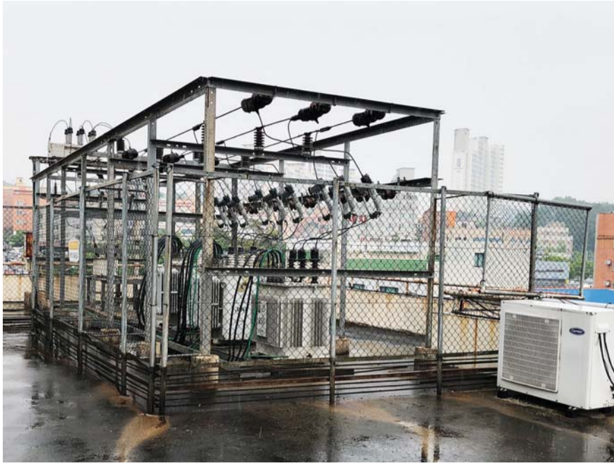
광주시 북구 양산동의 C아파트 상가 건물 3층 옥상에 설치된 고압변압기. 설치된 지 20년이 지나면서 아래층 상가들이 변압기 하중을 견디지 못해 곳곳에 금이 가는 등 안전 사고에 노출돼 있다.
