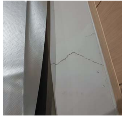
전시관 바닥을 덮어 놓은 깔개를 찢히자 벽으로 이어지는 균열이 나타났다.
