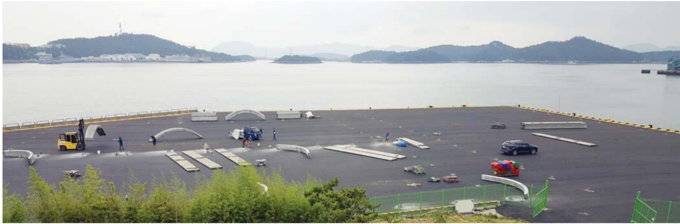
제1회 섬의 날 기념행사가 열릴 옛 해양부두 전경. 목포시는 최근 포장공사를 완료하고 메인무대와 전사행사를 위한 대형 텐트 설치 공사가 한창이다. 주차장 옆 잔디가 심어진 공간에는 야간행사 진행을 위해 25m 높이의 조명타워가 설치된다. /목포=고규석 기자 yousou@
