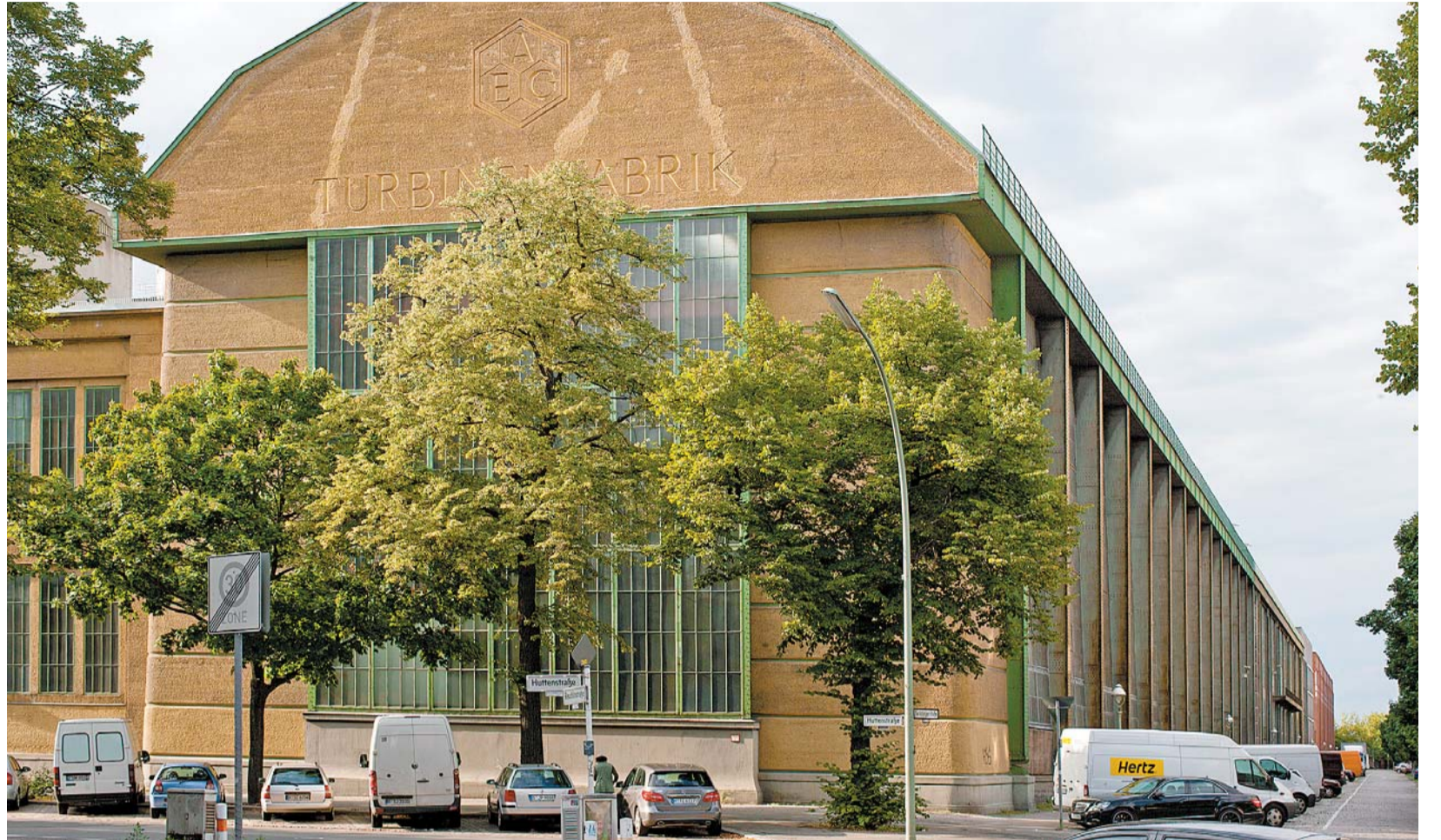
페터 베렌스가 설계한 베를린 AEG 터빈공장은 근대 건축의 효시로 여겨진다. 철골·유리·시멘트로 된 세워진 이 건물은 그로피우스의 건축설계에 큰 영향을 미쳤다. [사진 윤광준]
