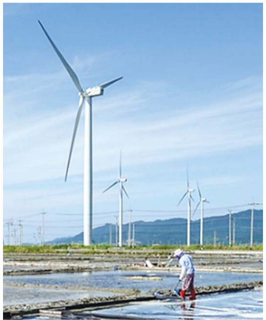
영광군 백수염전 일대에 늘어난 풍력발전기.
