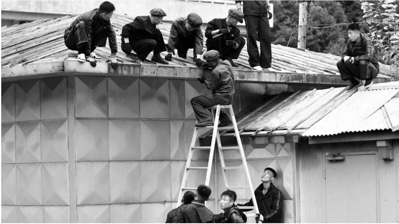
23일 유엔사에 따르면 남북한과 유엔사는 3자 협력으로 지난 12~14일 서울간 JSA 내 군사정전위원회 회의실 건물 지붕 등을 공사했다. 북한 측 작업 인력이 유엔사 승인 아래 JSA 내 군사분계선(MDL)을 넘나들며 보수 공사를 했다. /연합뉴스
