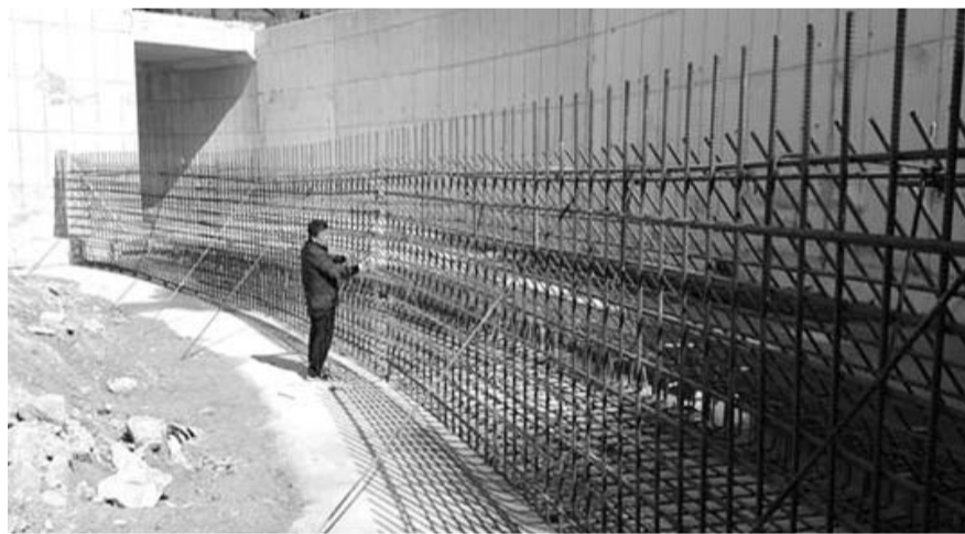
29곳에 대해서도 권양기 보수와 제당 그라우팅, 수문 및 방수로 정비, 위험표지판 설치 등을 완료·추진한다. /남원=백선 기자 bs8787@
