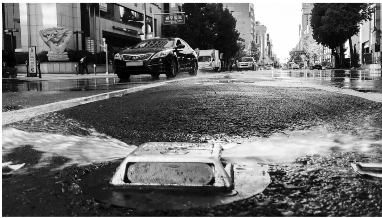
미세먼지 예방 '쿨링로드' 시험 가동 29일 광주시 동구 금남로 중앙상에 설치한 '쿨링로드'가 시험 가동을 하고 있다. 쿨링로드는 봄가을엔 미세먼지 저감장치로, 여름 폭염엔 더위를 식혀주는 역할을 한다. /최현배 기자choi@kwangju.co.kr
